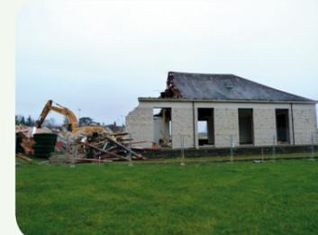
Des matériaux issus de la démolition ont été recyclés, comme les pierres calcaires utilisées pour combler le vide sanitaire, ou les huisseries.
